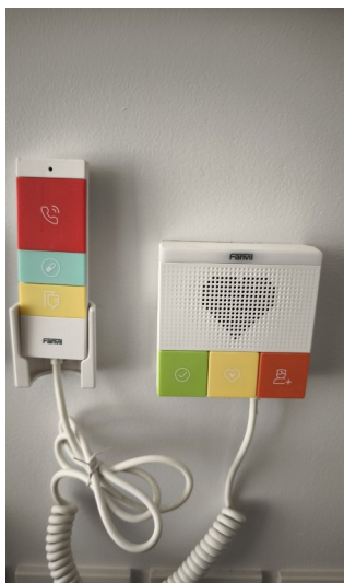
จากซ้าย: จุดเรียกในห้องพัก · หัวเตียงและปุ่มสายถึง · เครื่องแม่ที่ลิโอบบี้
