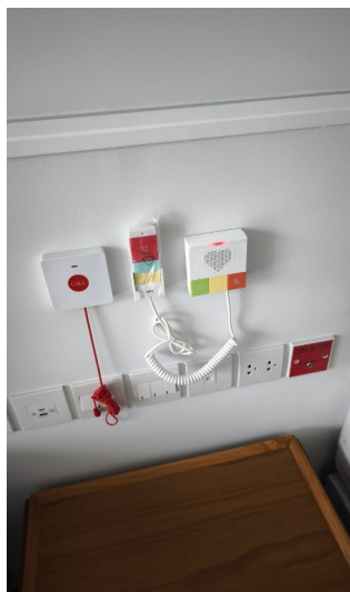
จากซ้าย: จุดเรียกในห้องพัก · หัวเตียงและปุ่มสายถึง · เครื่องแม่ที่ลิโอบบี้
