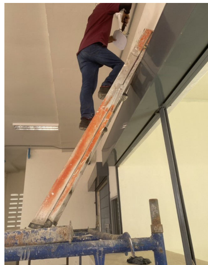
ยึด Anchor เข้ากับผนังตามแนวอาคาร
