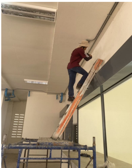
ติดตั้ง Anchor บนผนังอาคารใหม่
