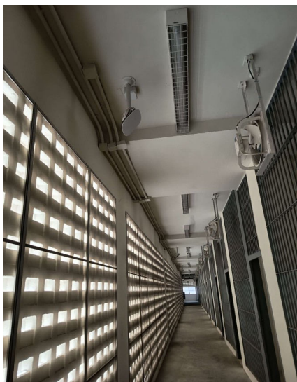
Anchor ติดตั้งตลอดแนวทางเดิน
