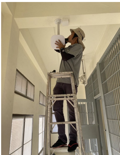
ติดตั้ง Anchor บนเพดานอาคาร
